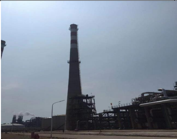
硫磺回收装置尾气焚烧炉
