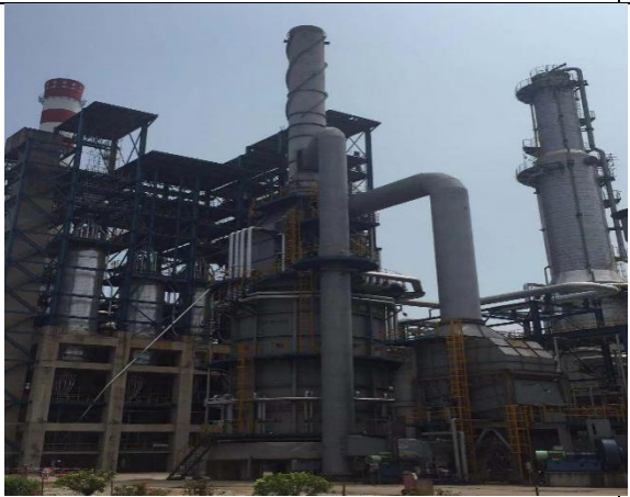
催化重整装置稳定塔重沸炉
