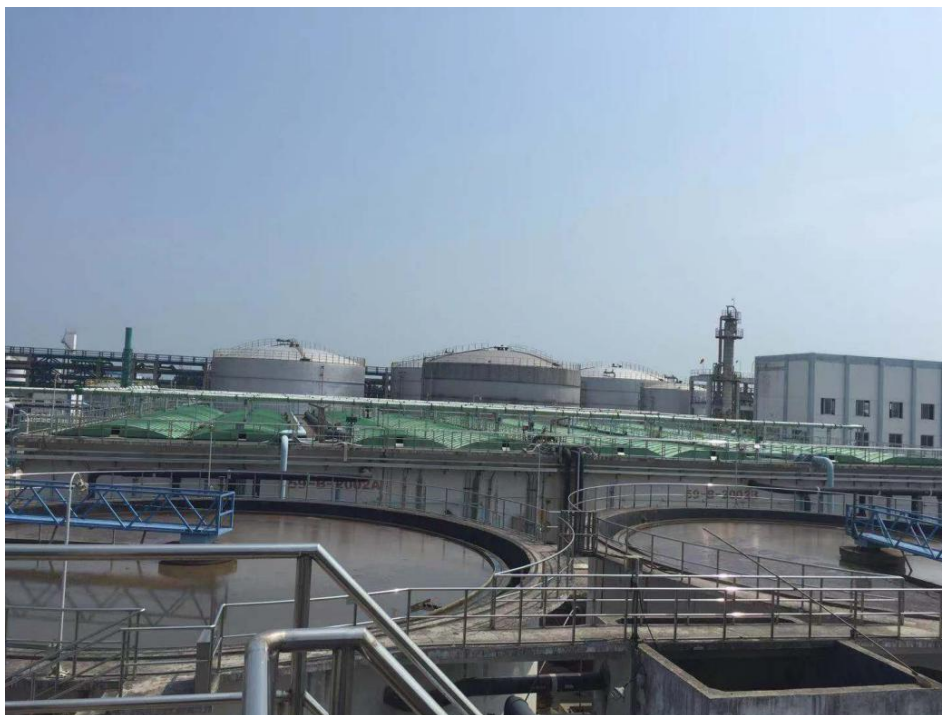
图 4-10 含盐污水处理场
