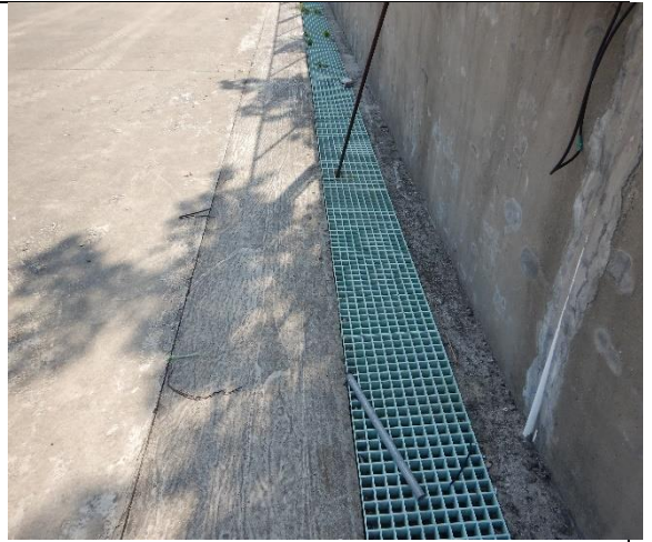
暂存间外的收集沟
