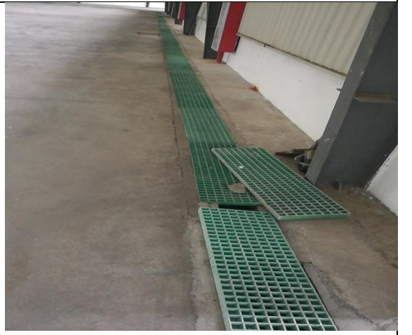
危废暂存间收集沟
